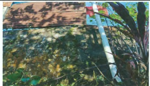
Foto 6: Mantenimiento del muro de contención con aplicación de repellado en toda su estructura debido a su exposición a la intemperie.
