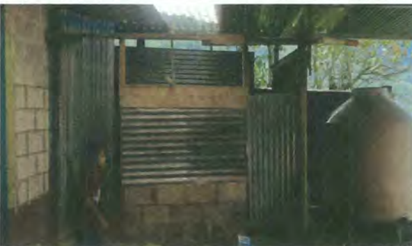
Foto 3: Remozamiento del área de letrina con complemento de pared de block e instalación de puertas.
